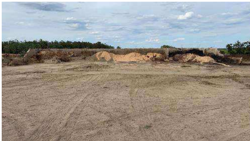
Figura 3-1: Área de recepción y acopio de residuos
