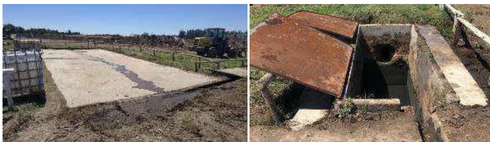
Figura 3-5: Zona de lavado de maquinaria (izq.) y sedimentador (der.)
